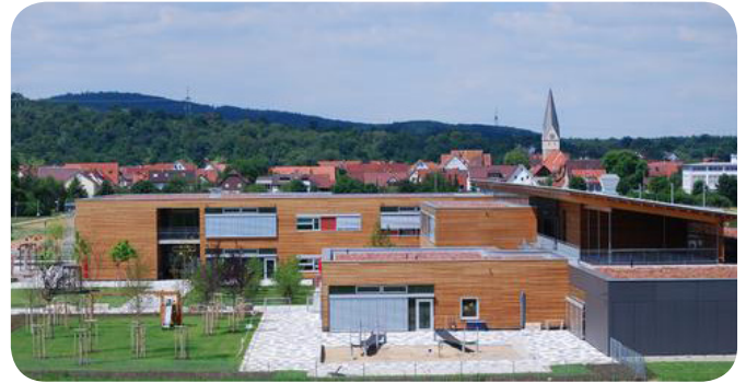
Paradebeispiel für klimaangepasstes, ökologisches Bauen in Schulen: Körper- und Sprachbehinderte Verbundschule in Nürtingen (BW). Bauobjekt beinhaltet Holz als Baumaterial, extensive, wärmedämmende Dachbegrünung, hoher Anteil an Verschattungsflächen, überdachte Dachterrasse, hoher Grünanteil im Außenbereich, Nachtlüftungsklappen für Frischluftaustausch. Quelle: www.zinco-greenroof.com .
